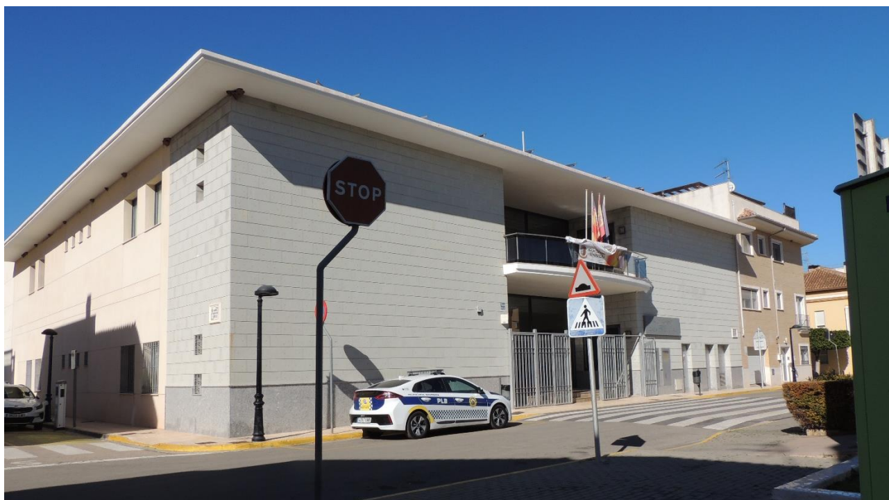
Vista de la Casa de la Música y la Casa consistorial, dos obras ejecutadas recientemente con dinero público en las que se renunció a promover una arquitectura de calidad. Fuente: AUG-ARQUITECTOS SLP
